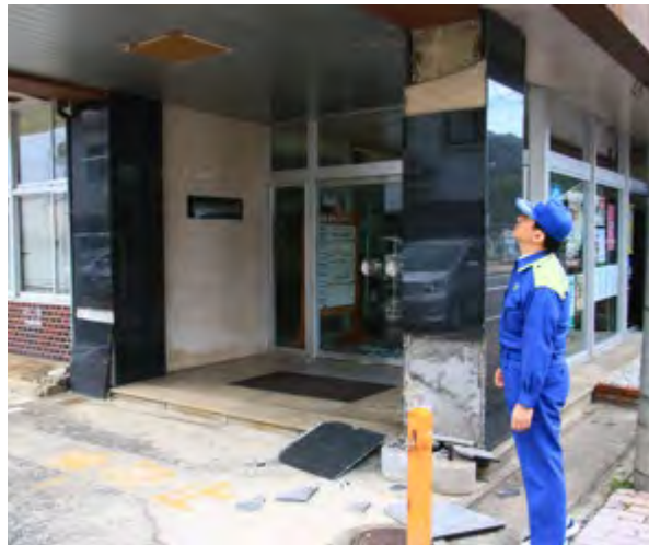
倉吉商工会議所 外壁等落下
