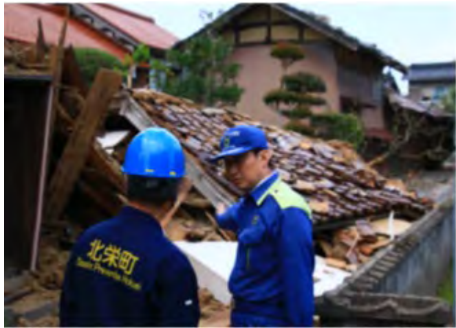
北栄町 家屋倒壊
